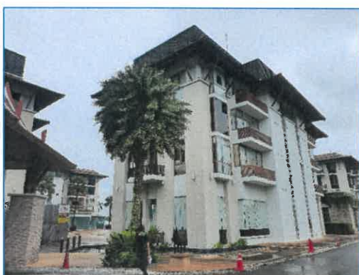
ภาพถ่ายที่ 2.2-14 เสาหล่อฟ้า สายหล่อฟ้า
