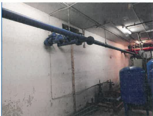
ภาพถ่ายที่ 2.2-9 น้ำสำรองดับเพลิงพร้อมระบบปั้มน้ำดับเพลิง
