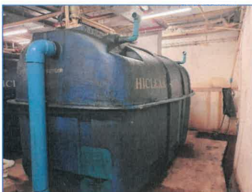
ภาพถ่ายที่ 2.2-4 บ่อกักน้ำทิ้งเพื่อนำน้ำกลับมาใช้
