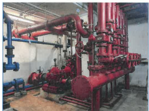
ภาพถ่ายที่ 2.2-9 น้ำสำรองดับเพลิงพร้อมระบบปั้มน้ำดับเพลิง
